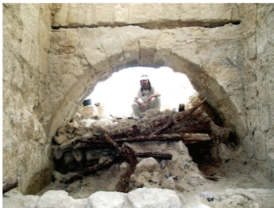
איור 16: קיר תמך מעץ מימי בר כוכבא שנבנה לתמיכת מנהרה אשר נחפרה בתוך מילוי העפר שסתם את פרוזדור הקשתות
