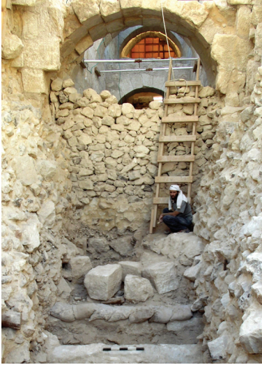
איור 11: קיר תמך שנבנה בעת סתימתו של פרוזדור הקשתות בסוף ימיו של הורדוס
