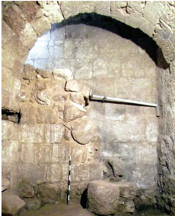
איור 20: כניסה אל מרתף בעל קמרון שמדרום לחדר הכניסה
